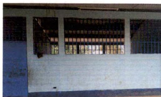
Foto 12: Pintura de muros exteriores e interiores
