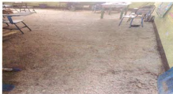
Foto 16: Reparación de piso de torta de concreto
