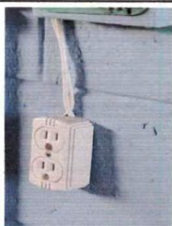
Foto 9: Sustrucción de interruptores dobles
