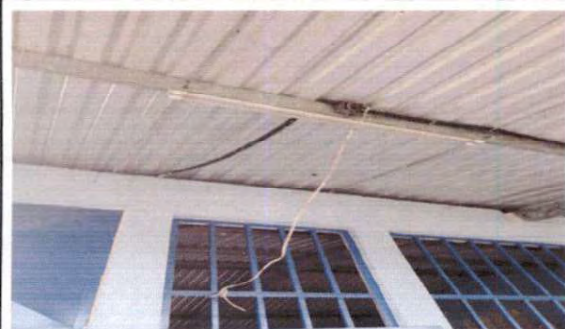
Foto 13: Reparación de cableado eléctrico
