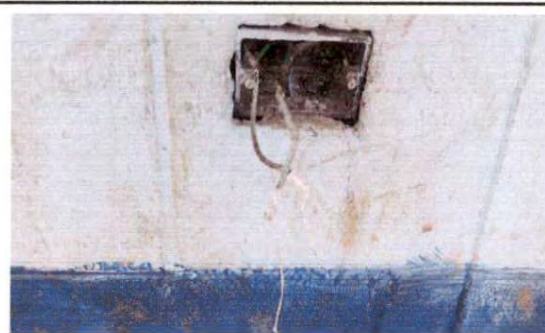
Foto 10: Sustrucción de tomacorrientes dobles
