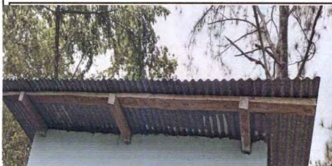
Foto 15: Sustitución de estructura de soporte de madera, por metal
