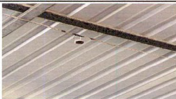
Foto 7: Sustrucción de focos ahorradores
