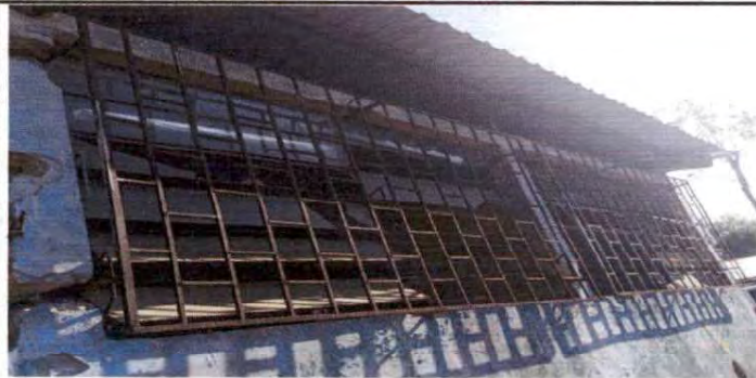
Foto 4: Sustrucción de balcones de metal
