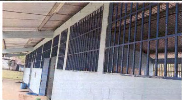
Foto 3: Mantenimiento a balcones de metal
