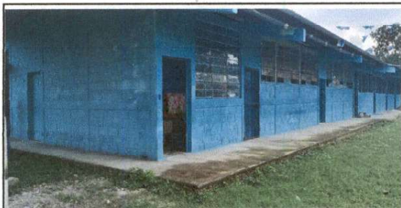
Foto 5: Pintura en muros exteriores e interiores
