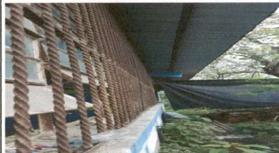
Foto 4: Mantenimiento a balcones de metal
