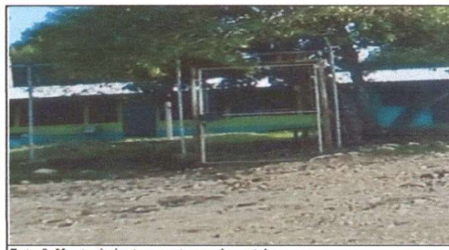
Foto 6: Mantenimiento a portones de metal
