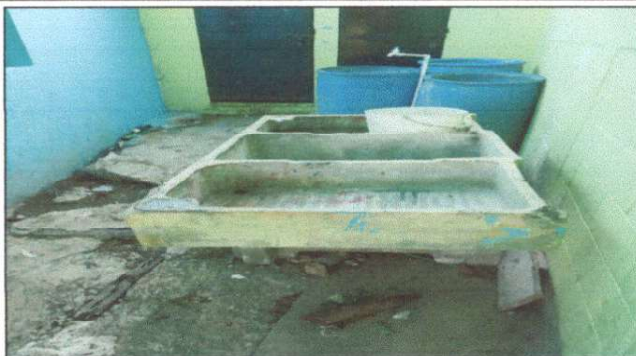
Foto 2: Sustrucción de pila de cemento de dos lavaderos
