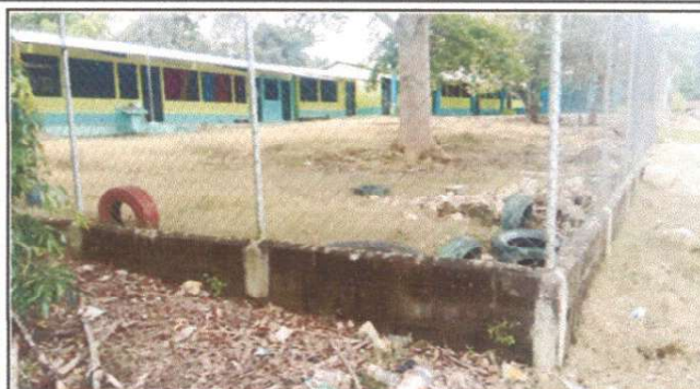
Foto 8: Reparación de muro perimetral de block con tubo hg y malla galvanizada, soleras intermedias
