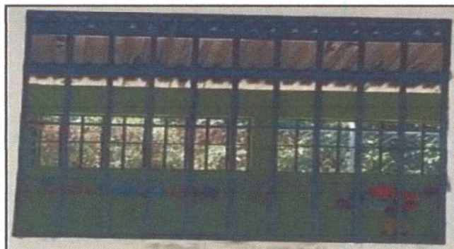
Foto 9: Sustitución de balcones de metal
