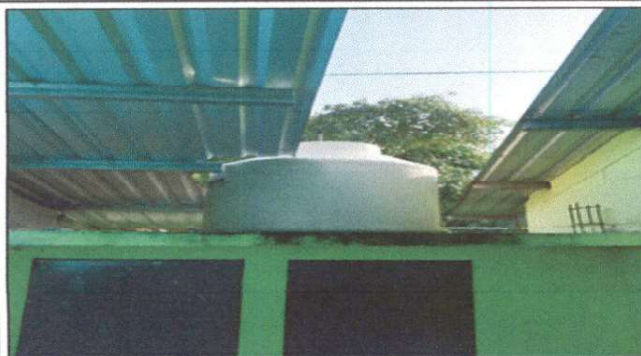
Foto 1: Sustrucción de depósito de agua 1700 lt
