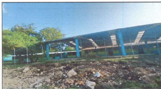
Foto 3: Pintura en muros exteriores e interiores
