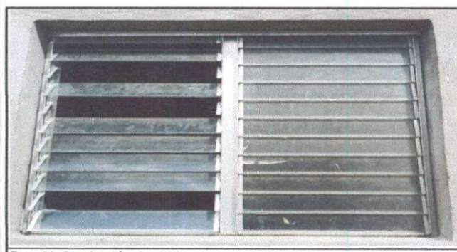
Foto 11: Sustitución de vidrio
