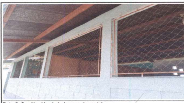
Foto 5: Sustrucción de balcones de metal
