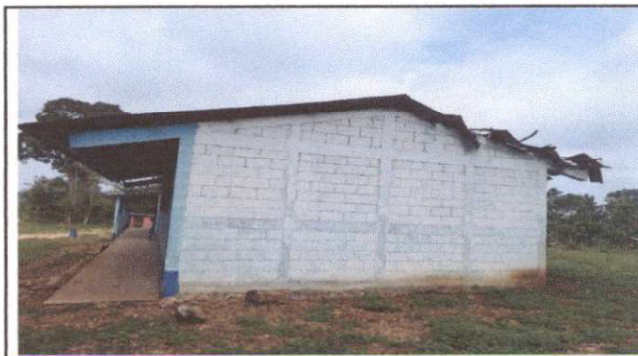
Foto 4: Pintura en muros exteriores e interiores
