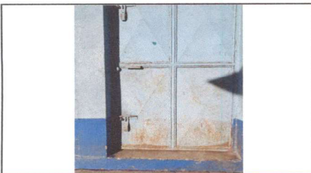
Foto 3: Sustrucción de puertas
