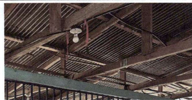
SUSTITUCIÓN DE PLAFONERAS
