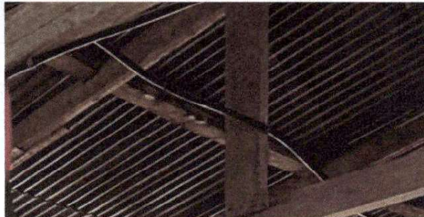
REPARACION DE CABLEADO ELÉCTRICO
