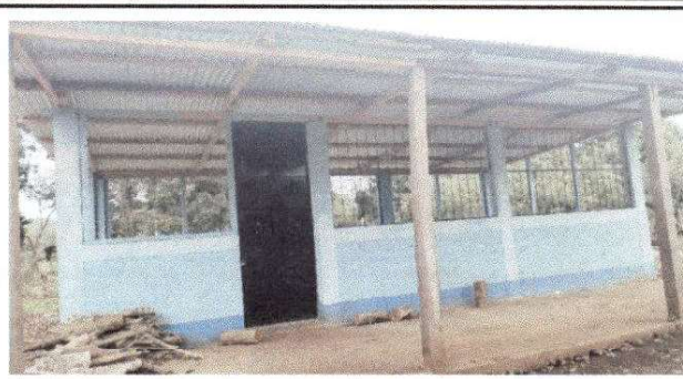
SUSTITUCION DE BALCON DE METAL
