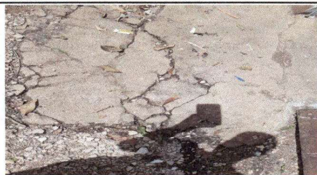
SUSTITUCION DE TORTA DE CEMENTO LIQUIDO
