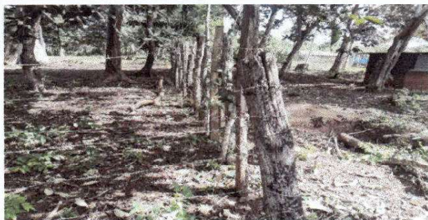
REPARACION DE CERCO DE ALAMBRE DE PUA
