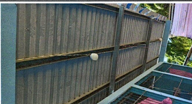
Foto 3: REPARACION DE SISTEMA ELÉCTRICO
