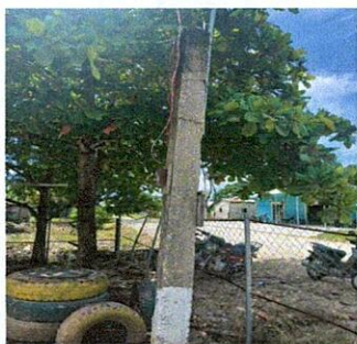
Foto 5: Reparación de muro
