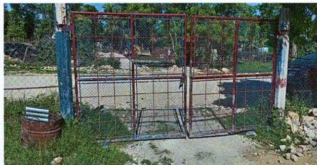
Foto 2: Sustitución de portón de metal
