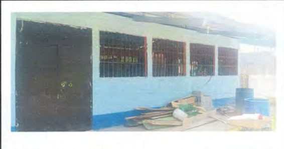
Foto 6: Pintura en muros exteriores e interiores
