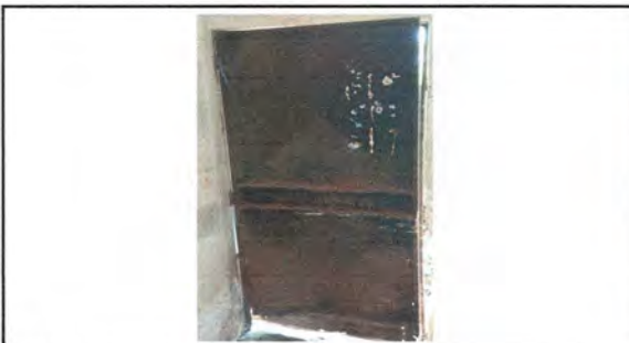
Foto 3: Sustrucción de puerta
