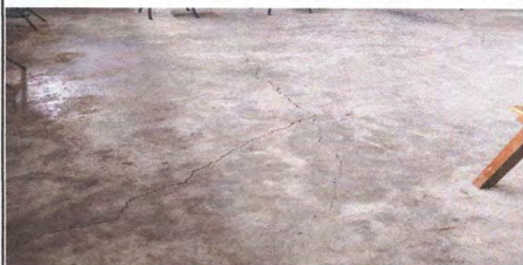
Foto 7: Sustrución de piso de torta de concreto
