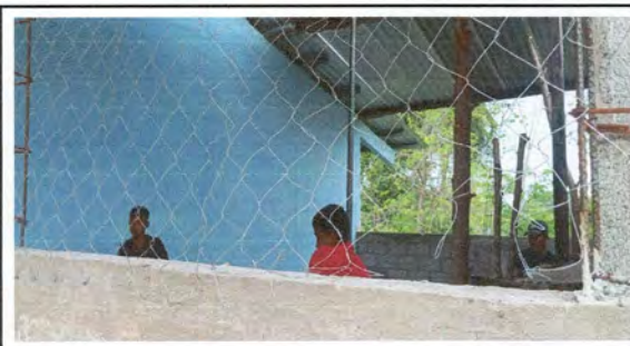
Foto 4: Sustrucción de balcones de metal
