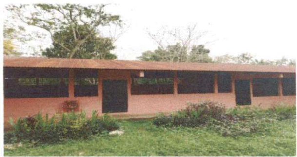
SUSTITUCION DE LAMINA TROQUELADA ALUZINC CALIBRE 26
