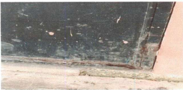
SUSTITUCIÓN DE PUERTAS
