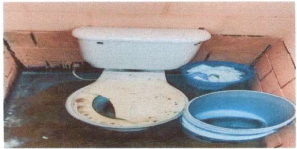
SUSTITUCION DE INODOROS
