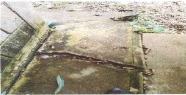
SUSTITUCION DE PISO DE TORTA DE CEMENTO LIQUIDO
