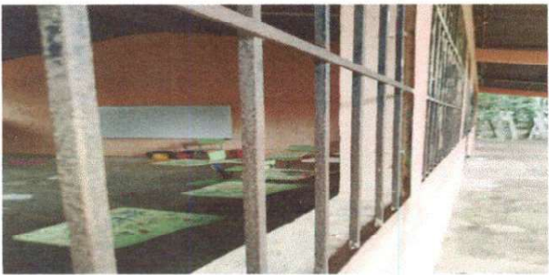
SUSTITUCIÓN DE BALCON DE METAL
