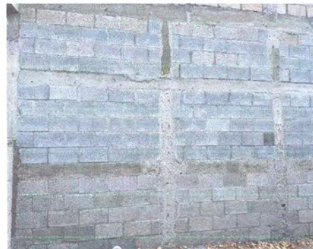
Foto 4: Reparación de muros y bigas de concreto (cernido y repello)
