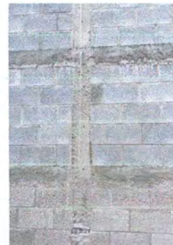
Foto 6: Reparación de sistema eléctrico
