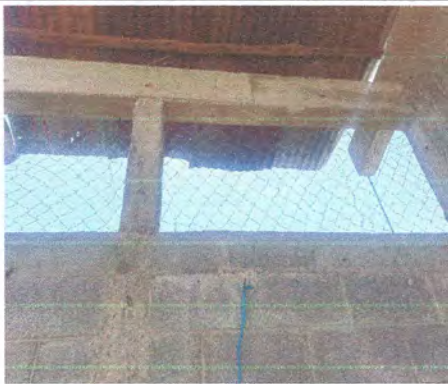
Foto 3: Fabricación e instalación de balcones y puerta
