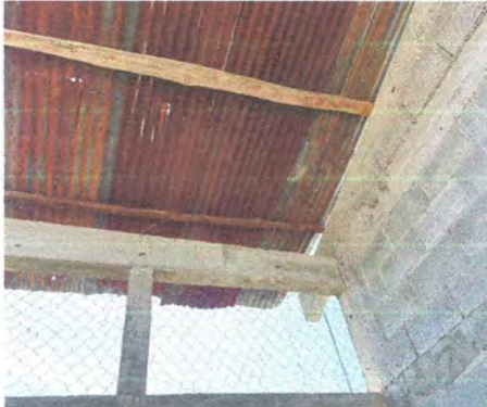
Foto 1: Sustitución de lámina por lámina troquelada calibre 26
