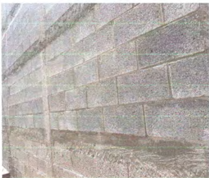
Foto 5: Pintura interior y exterior
