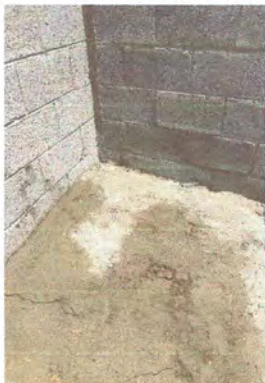
Foto 7: Remozamiento en torta de cemento y piso
