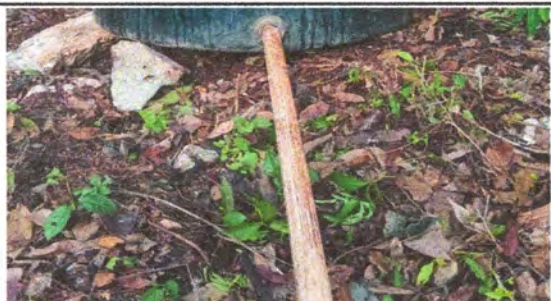
Foto 1: Sustrucción de tubería línea principal
