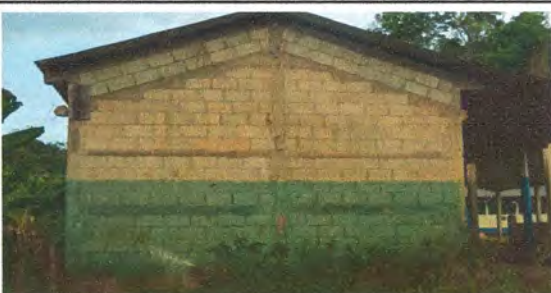
Foto 5: Repello en muro
