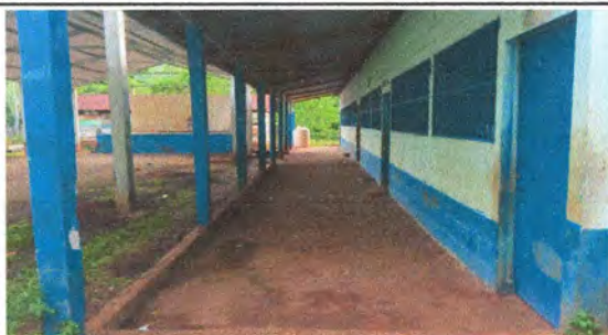
Foto 3: Sustrucción de piso de torta de concreto
