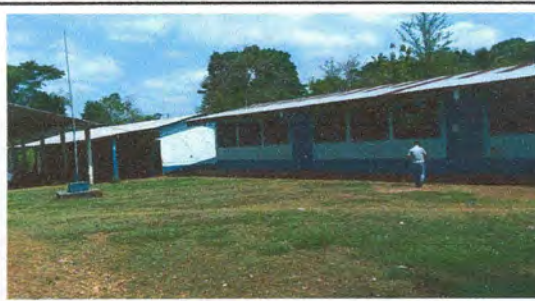
Foto 2: Pintura en muros exteriores e interiores
