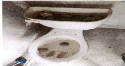
Foto 10. Sustitución de inodoro
