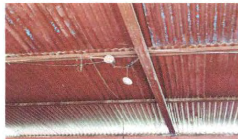
Foto 12 Sustitución de plafoneras
