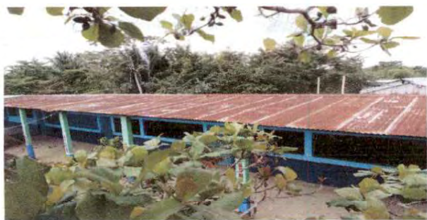
Foto No. 1 Sustrucción de lámina, por lámina troquelada aluzinc calibre 26
