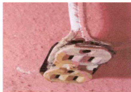
Foto No. 14 Sustitución de tomacorrientes dobles
