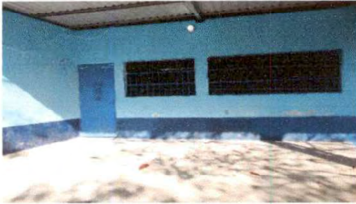
Foto 9: Pintura a muros exteriores e interiores
