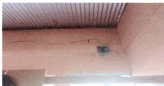
Foto 16 Reparación de cableado eléctrico
