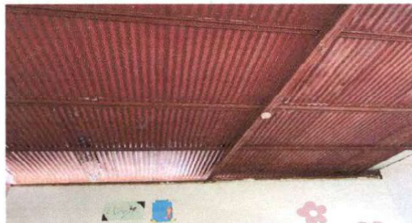
Foto 4: Mantenimiento a estructura de metal
