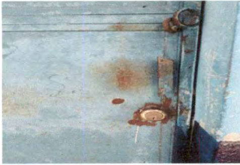
Foto No. 7 Sustitución de chapa
