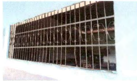
Foto No.8 Mantenimiento a balcones de metal
