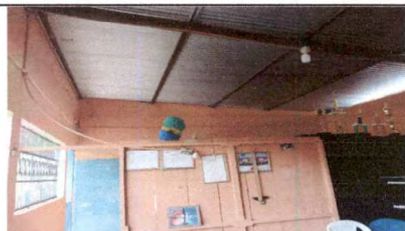
Foto 17 Sustitución de ducto eléctrico+ accesorios.
