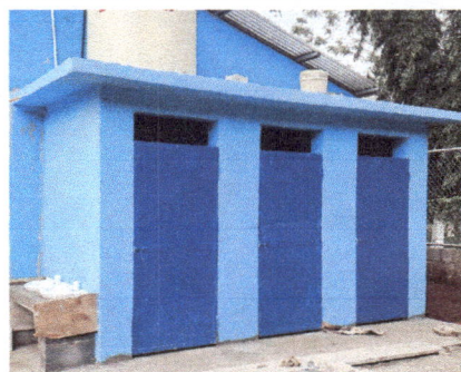
Foto 4: Reparación de muro perimetral de block.
