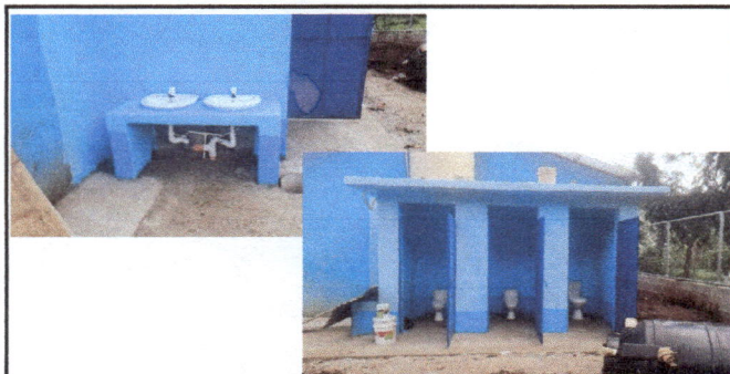
Foto 5: Sustitución inodoro; Sustitución lavamanos
