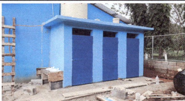
Foto 1: Sustitución de puerta en servicios sanitarios
