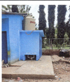
Foto 2: Sustitución de piso de torta de concreto
