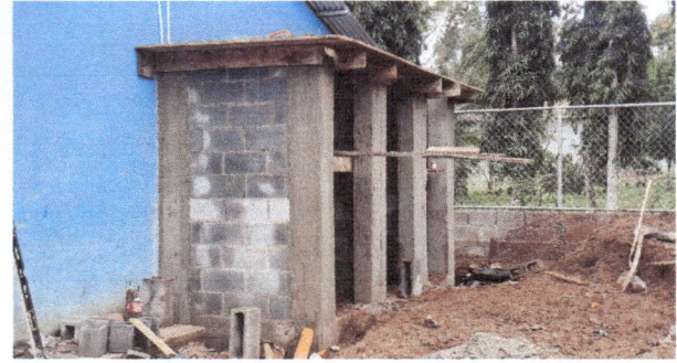
Foto 4: Reparación de muro perimetral de block.
