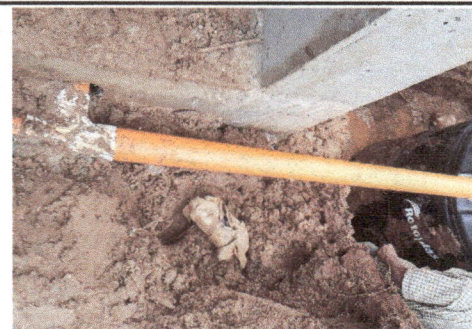
Foto 6 :Sustitución de tubería línea principal
