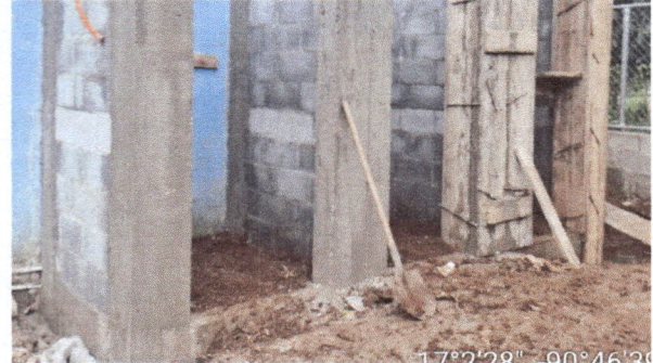
Foto 2: Sustitución de piso de torta de concreto
