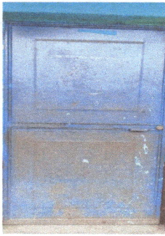
Foto 1: Sustitución de puerta en servicios sanitarios
