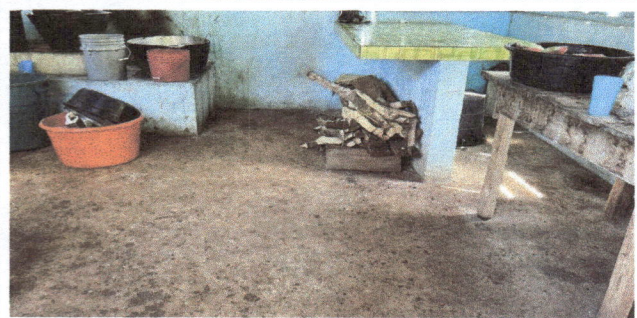
Foto 2: Sustitución de piso de torta de concreto
