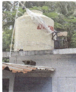
Foto 3: Pintura en muros exteriores e interiores; Instalación de tubería principal de pvc; Sustitución de depósito de agua 1000 lt
