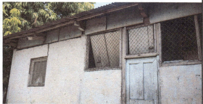
Foto 4: Reparación de muro perimetral de block.
