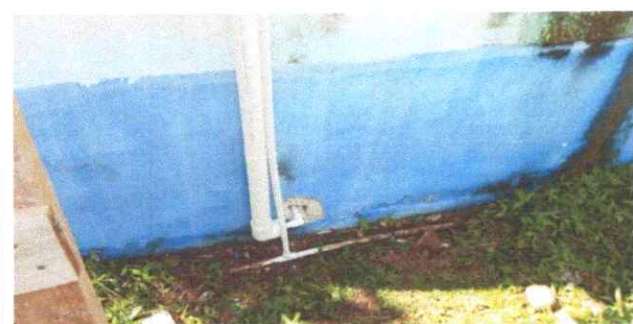
foto 5. sustitucion de tuberia principal
