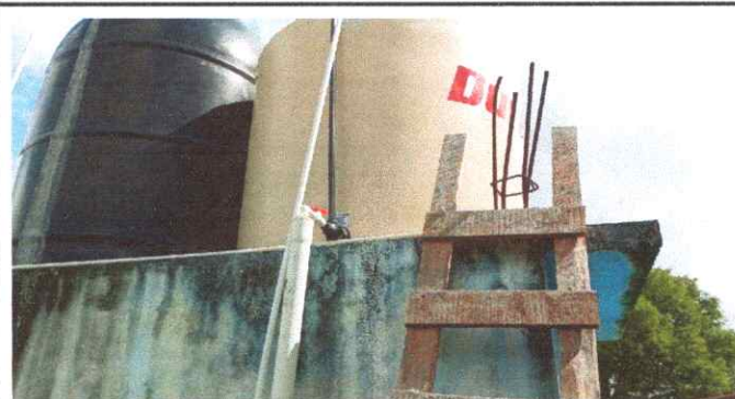
foto No. 8 sustitución de accesorios de deposito de agua.
