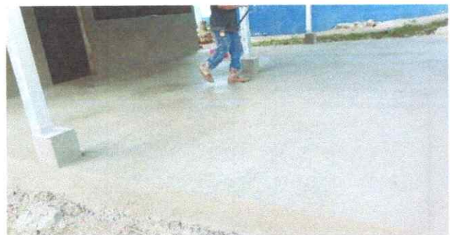
foto 3. sustitucion depiso de torta de concreto
