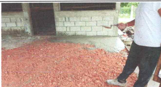
foto 3. sustitucion depiso de torta de concreto
