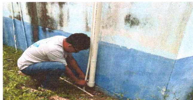
foto 8. sustitución de accesorios de deposito de agua
