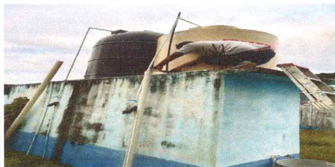
foto No 7. sustitución de deposito de agua de 1,700 litros
