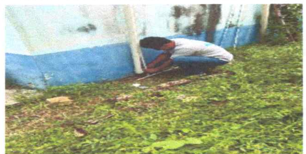
foto 5. sustitucion de tuberia principal
