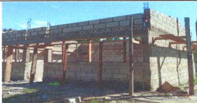
foto 6. reparacion de muro perimetral de block
