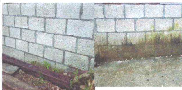
foto 6. reparacion de muro perimetral de block
