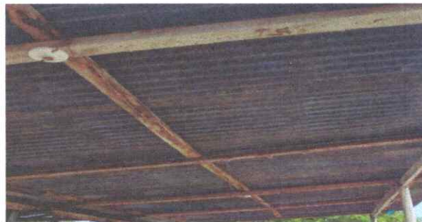
foto 2. sustitucion de estructura de soporte de madera, por metal
