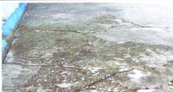
foto 3. sustitucion depiso de torta de concreto
