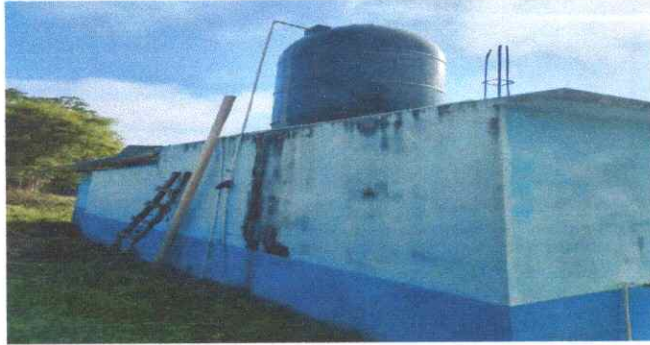
foto No7 sustitucion de deposito de agua de 1,700 litros
