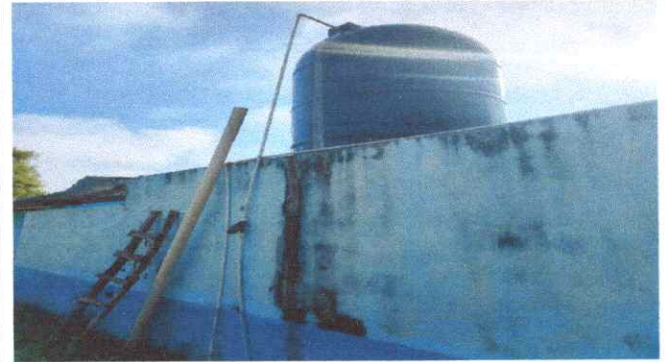
foto No. 8 sustitucion de accesorios deposito de agua
