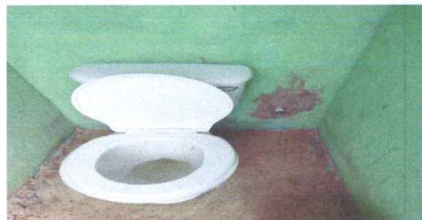
foto 4. sustitucion de accesorios de inodoro
