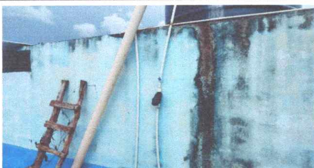
foto 5. sustitucion de tuberia principal
