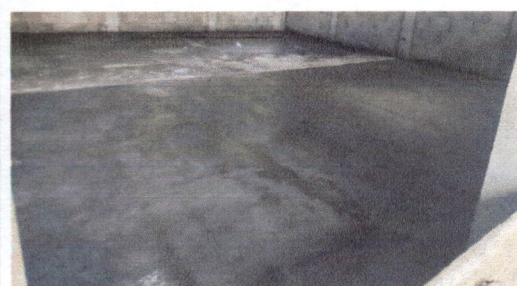
Foto 2: Sustrucción de piso de torta de concreto
