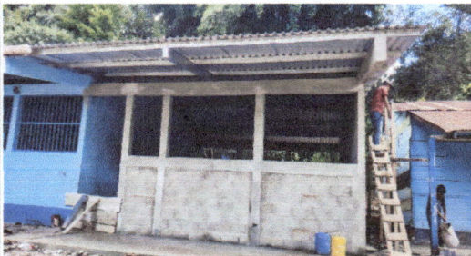
Foto 4: Reparación de muro perimetral de block.
