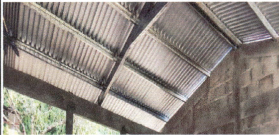
Foto 3: Sustrucción de estructura de soporte de madera, por metal
