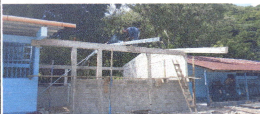
Foto 4: Reparación de muro perimetral de block.
