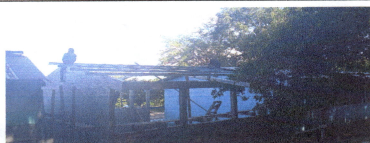
Foto 3: Sustrucción de estructura de soporte de madera, por metal
