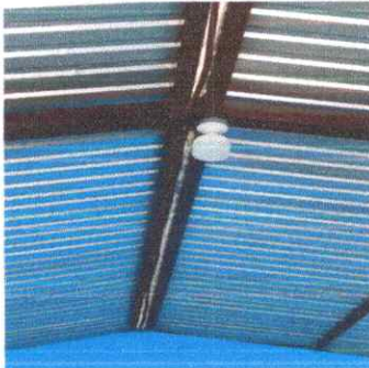
Foto 3: Sustitución de plafoneras
