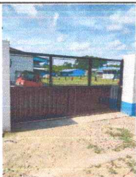
Foto 3: Sustitución de portón de metal
