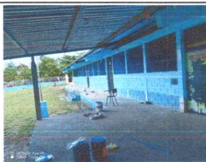
Foto 4: Mantenimiento a balcones de metal
