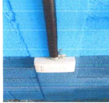
Foto 2: Instalacion unidades de fuerza (tomacorriente) Incluye cable eléctrico
