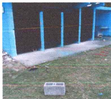
Foto 2: Sustitución de puerta en servicios sanitarios
