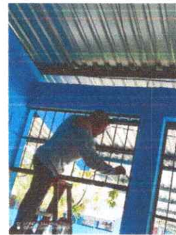
Foto 4: Mantenimiento a balcones de metal
