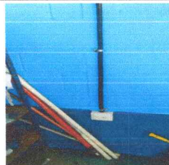
Foto 2: Instalación de unidades de fuerza (tomacorriente) Incluye cable eléctrico
