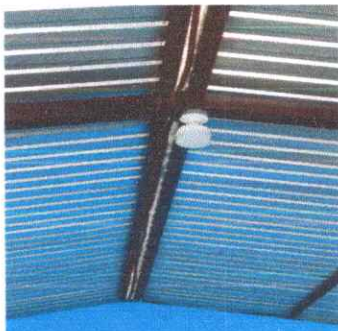
Foto 1: Instalación de unidades de luz (incluye interruptor, ducto y cable eléctrico)
