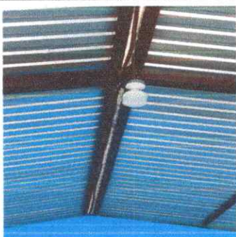
Foto 3: Sustitución de plafoneras
