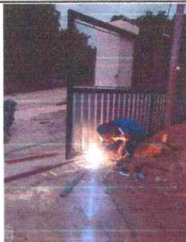
Foto 3: Sustitución de portón de metal
