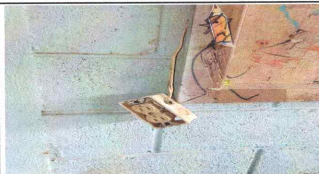
Foto 4: Sustitución de Tomacorrientes
