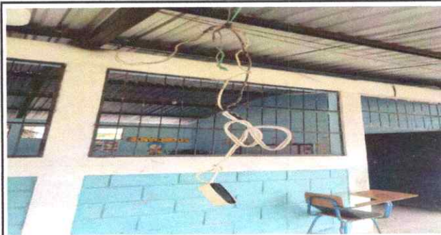
Foto 2: Instalación de unidades de fuerza (tomacorriente) incluye cable eléctrico
