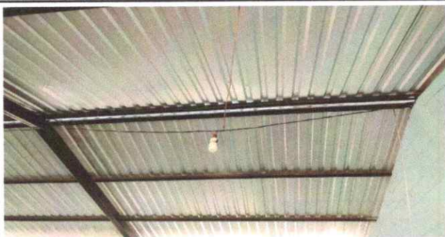
Foto 3: Sustitución de plafoneras
