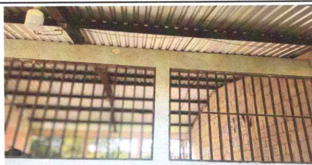
Foto 4: Mantenimiento a balcones de metal
