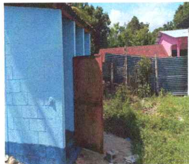
Foto 2: Sustitución de puerta en servicios sanitarios
