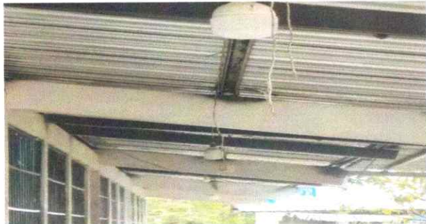
Foto 1: Instalación de unidades de luz (incluye interruptor, ducto y cable eléctrico)
