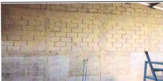
Foto 5: Pintura en muros exteriores e interiores
