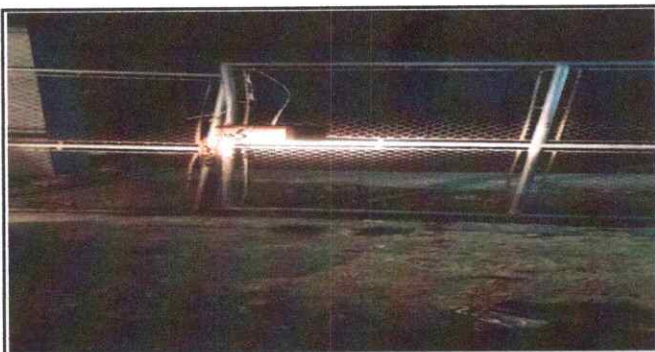
Foto 3: Sustitución de portón de metal
