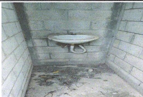
Foto 3: Sustrucción de lavamanos
