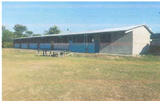
Foto 1: Sustitución de láminas por lámina troquelada alumiizinc calibre 26
