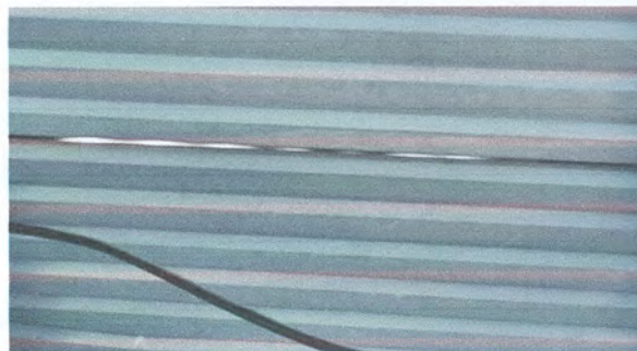
Foto: 6 Sustitución de lámina por lámina troquelada alumiizinc calibre 26
