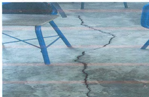
Foto: 4 Reparación de piso de las seis aulas
