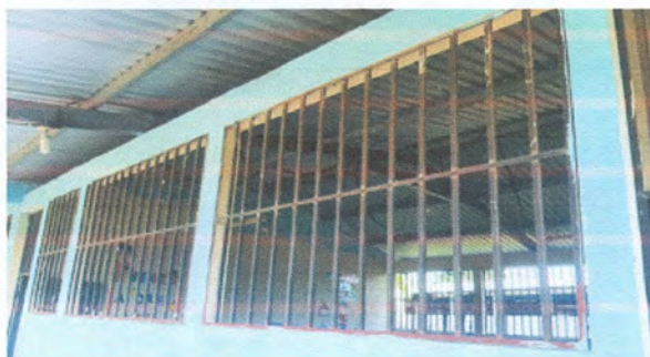
Foto: 3 Mantenimiento de balcones
