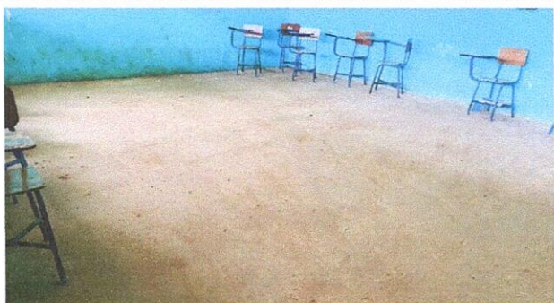
Foto: 7 sustitucion de piso de cemento liquido
