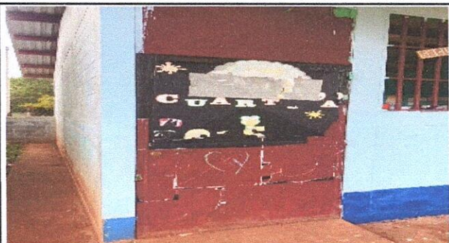
Foto 1: mantenimiento a estructura (lijado, cambio de tubo, ceillado, sujeción y aplicación de pintura)
