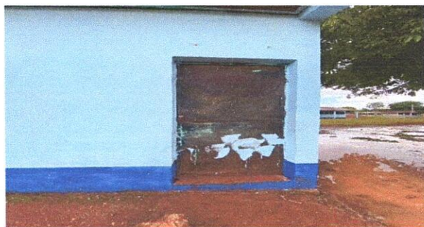
Foto 3: sustitución de puerta
