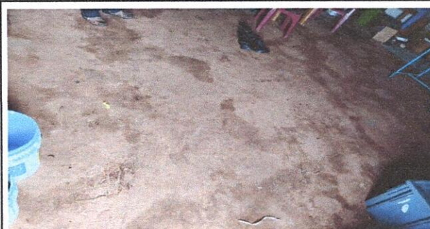
Foto 6: mejoramiento de piso liso por ceramico
