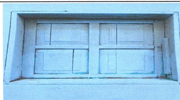
Foto 4: sustitución de ventana de madera por metal mas vidrio
