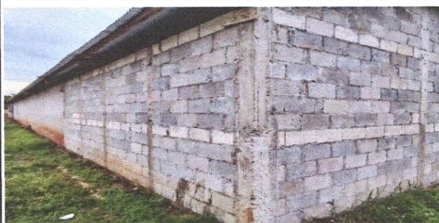
Foto: 8 repello en muro
