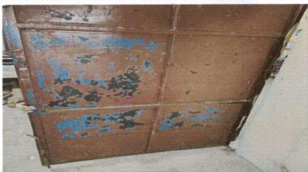
SUSTITUCION DE PUERTA
