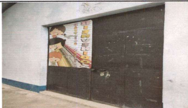
MANTENIMIENTO A PORTON DE METAL
