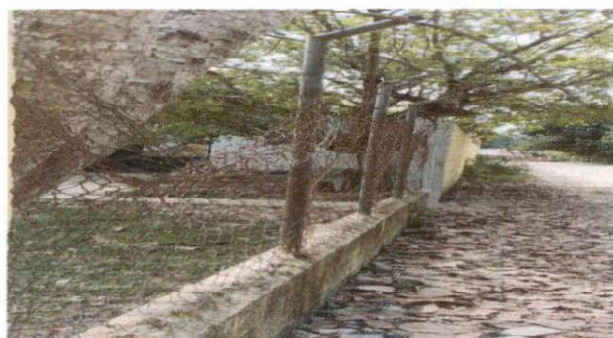
REPARACION DE TUBO HG Y MALLA GALVANIZADA
