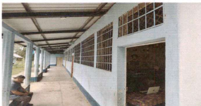
PINTURA EN MUROS EXTERIOR E INTERIOR
