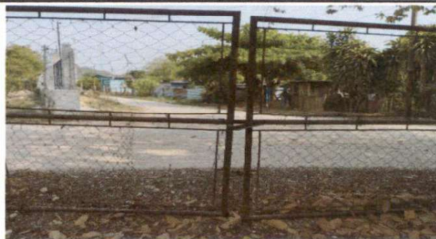
SUSTITUCION DE PORTON DE METAL
