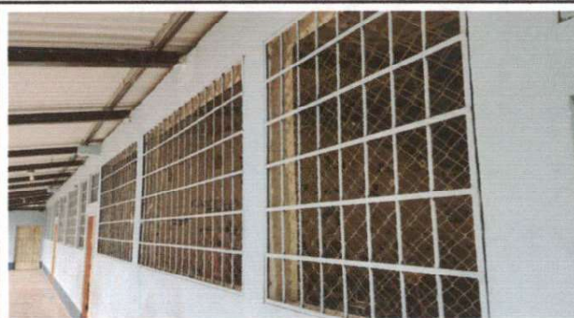
MANTENIMIENTO A BALCON DE METAL
