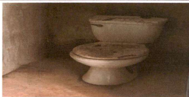
SUTITUCIÓN DE INODOROS
