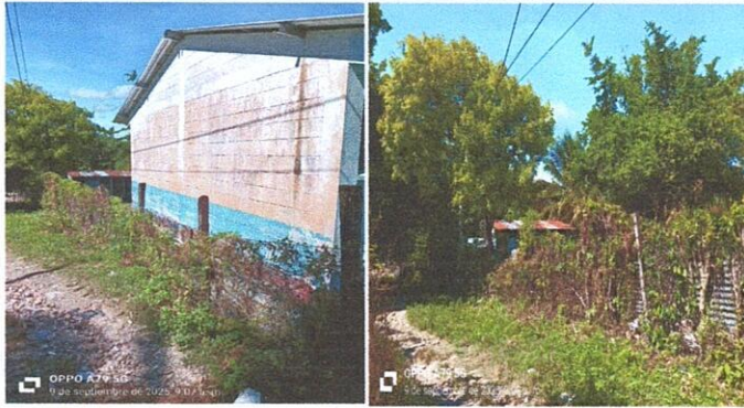
Foto1: REPARACION DE TUBO HG Y MALLA GALVANIZADA
