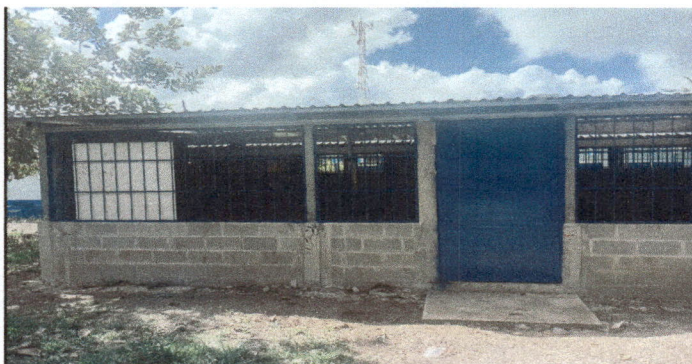
Foto 12: Instalación de puerta de metal de dos aulas
