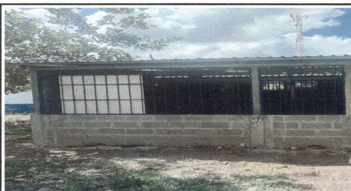
Foto 3: Sustitucion de balcones de metal
