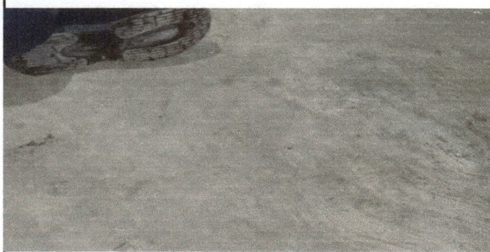
foto 4 : Reparacion de piso de torta de concreto
