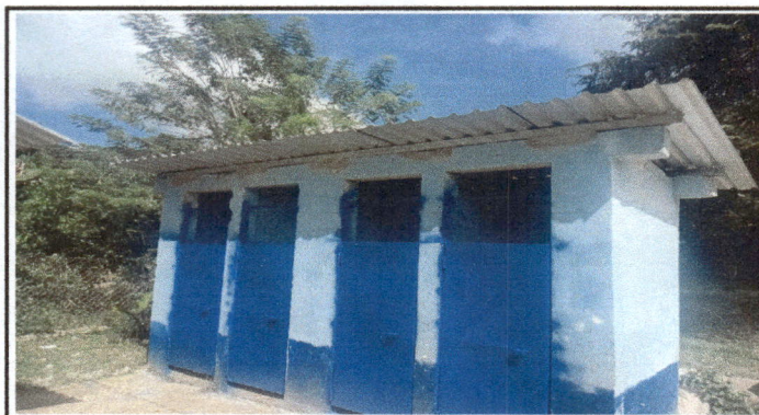
foto : 10 sustitución de lámina troquelada aluzinc calibre 26 del baño
