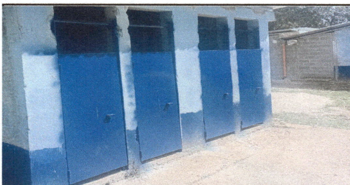
Foto 6: Mantenimiento a estructura (fijado cambio de tubo sepillado aplicacion de pintura a puerta de servicio a sanitario)
