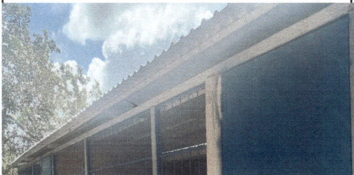
Foto 7: Sustitución de lámina, por lámina troquelada aluzinc calibre 26 para dos aulas
