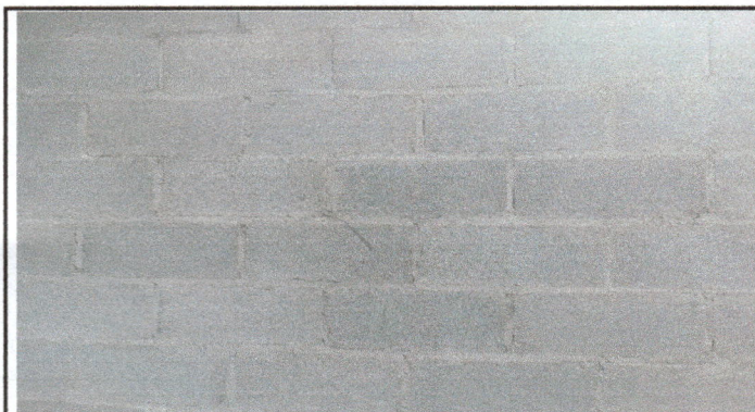
Foto 9: Sustitución de pared de lámina con pared de block
