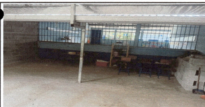
Foto 5: Sustitucion de canal de Metal
