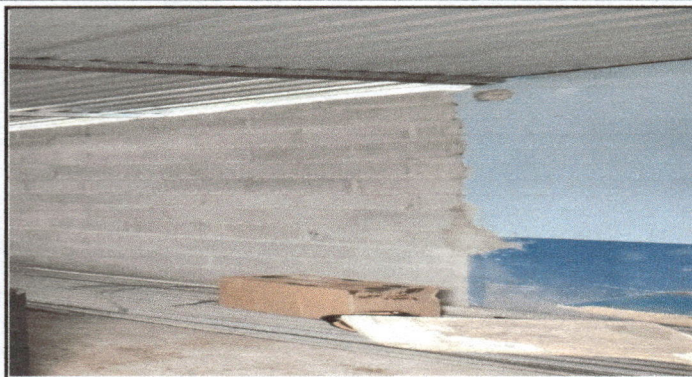
Foto 8: Sustitución de lámina aluzinc calibre 26 y pared de block a bodega
