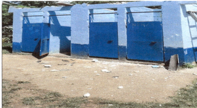
foto : 10 sustitucion de lamina troquelada aluzinc calibre 26 del baño
