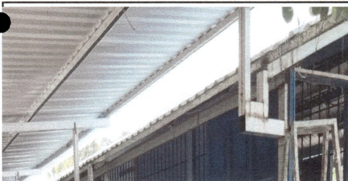
Foto 5: Sustrucción de canal de metal
