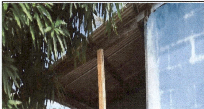
Foto 8: Sustitucion de lamina aluzinc calibre 26 y pared de block a bodega
