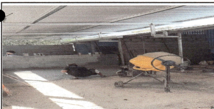
Foto 11: reparacion de piso a torta de concreto
