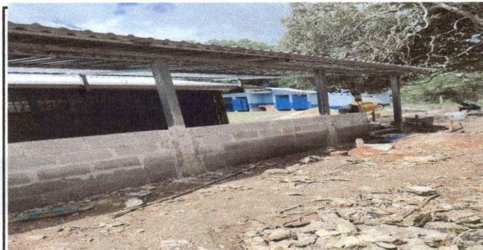
Foto 3: Sustrucción de balcones de metal
