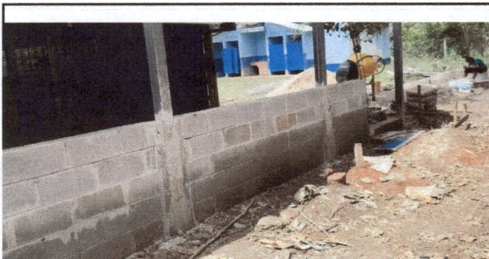
Foto 9: Sustitucion de pared de lamina con pared de block
