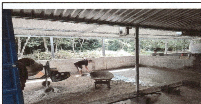
Foto 4: Reparación de piso de torta de concreto
