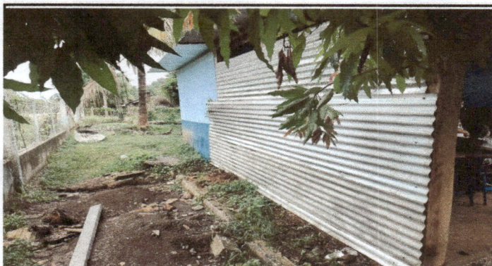
Foto 9: Sustrución de pared de lamina con pared de block
