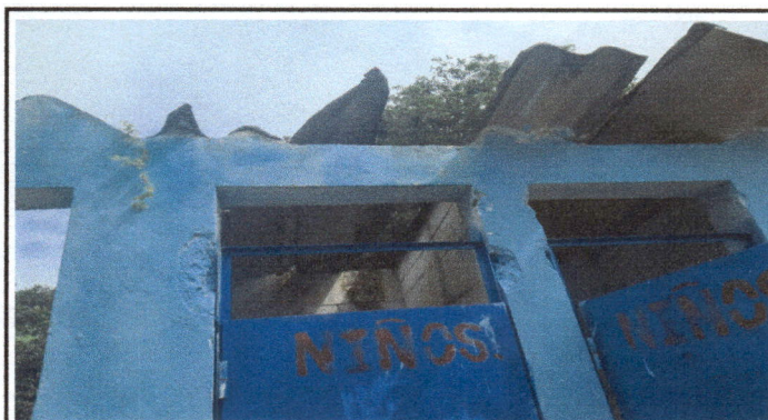
foto : sustrucion de lamina troquelada aluzic calibre 26
