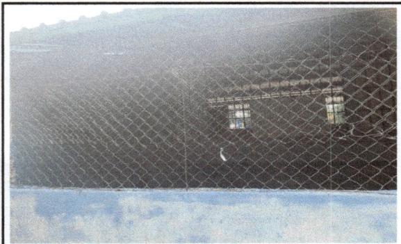
Foto 3: Sustrucción de balcones de metal
