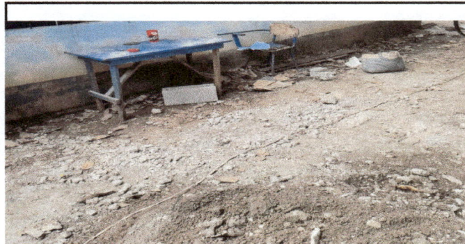
Foto 4: Reparación de piso de torta de concreto
