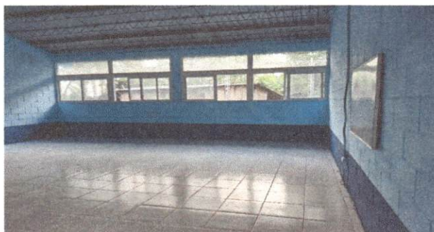
Foto 3: Sustitución de piso cerámica
