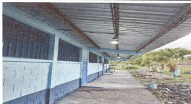
Foto 2: Sustitución de piso torta de concreto
