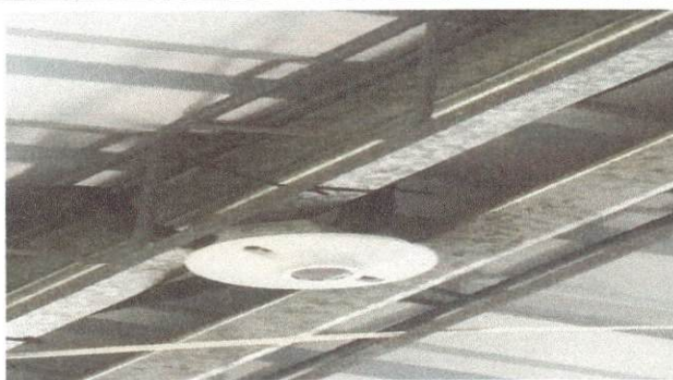
Foto 7: Sustitución de plafoneras
