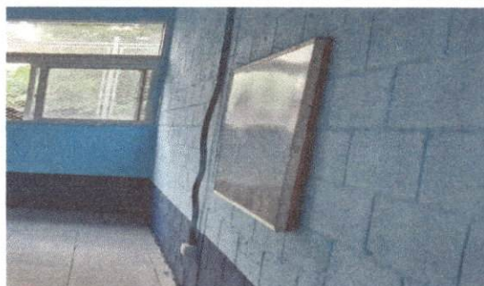
Foto 10: Sustitución de tomacorrientes dobles
