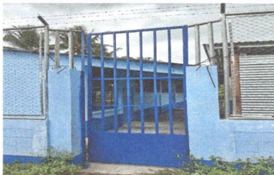
Foto1: Mantenimiento a portones de metal
