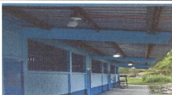
Foto 2: Sustitución de focos ahorradores
