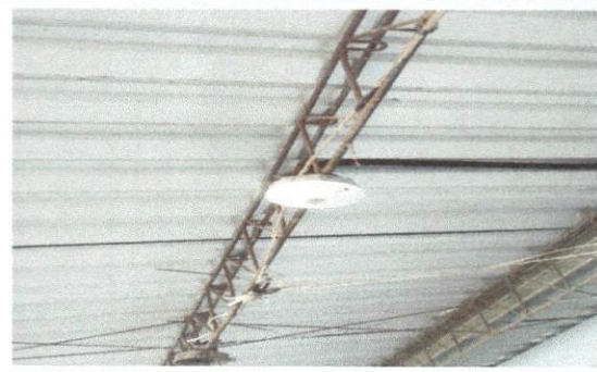
Foto 2: Sustitución de focos ahorradores
