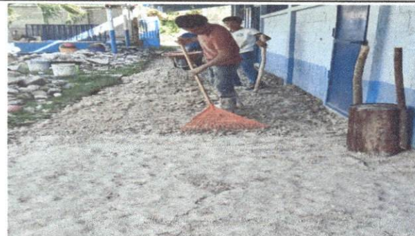
Foto 2: Sustitución de piso torta de concreto
