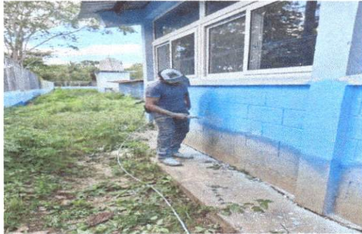
Foto1: Aplicación de pintura en muros interiores y exteriores
