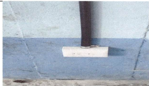
Foto 10: Sustitución de tomacorrientes dobles
