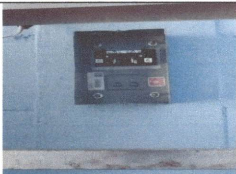
Foto11: Sustitución de flípones
