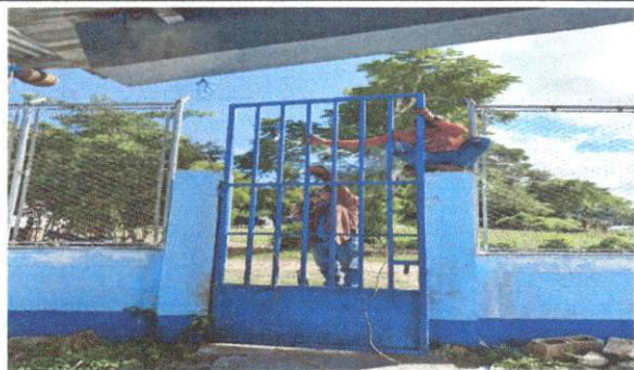
Foto 1: Mantenimiento a portones de metal
