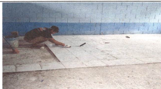
Foto 3: Sustitución de piso cerámica
