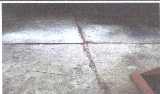
Foto 3: Sustitución de piso cerámica
