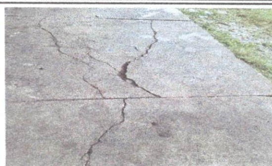
Foto 2: Sustitución de piso torta de concreto
