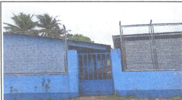
Foto 1: Mantenimiento a portones de metal
