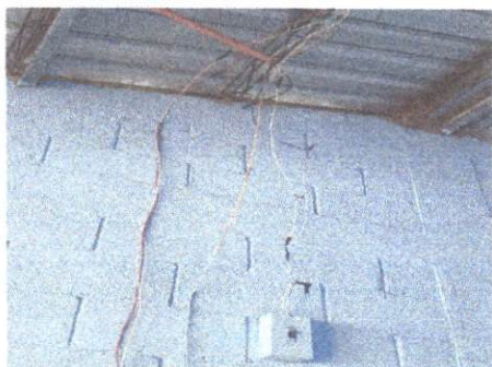
Foto11: Sustitución de filipones
