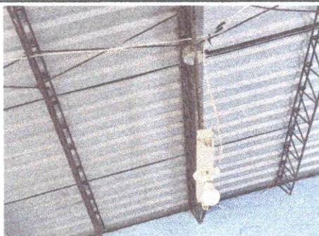
Foto 7: Sustitución de plafoneras
