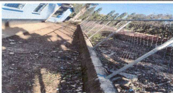
REPARACION DE TUBO HG Y MALLA GALVANIZADA
