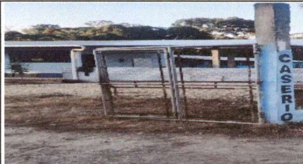
SUSTITUCION DE PORTON DE METAL
