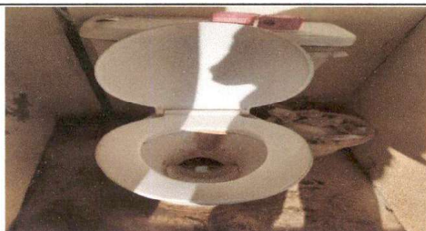
SUSTITUCIÓN DE INODOROS
