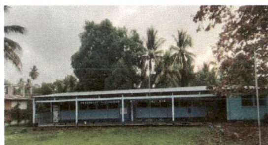
Foto 4: Pintura en muros exteriores e interiores
