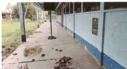
Foto 8: Sustitución de piso de torta de concreto
