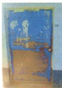
Foto1: Sustitución de lamina, por lamina troquelada aluzinc calibre 26
