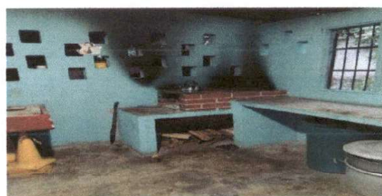
Foto 10: Instalación de azulejo en estufa rural
