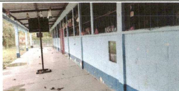
Foto 12: Mantenimiento de balcones de metal
