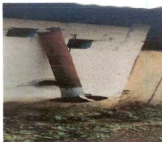
Foto 9: Sustitución de chimenea de metal
