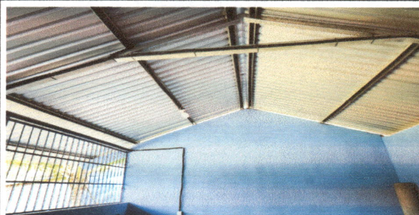
Foto 12:Repello en paredes de cocina
