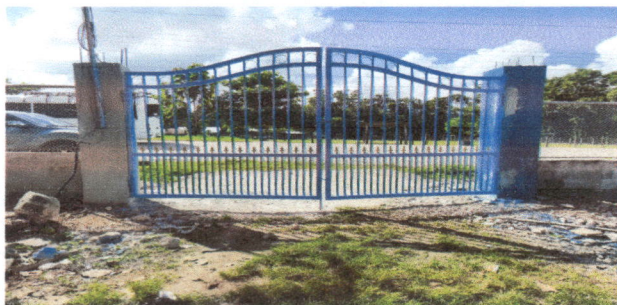
Foto 13 :Sustrucción de portón de metal
