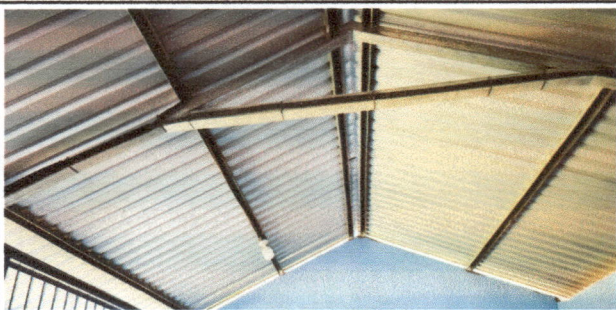
Foto 5: Sustrucción de estructura de soporte de madera, por metal
