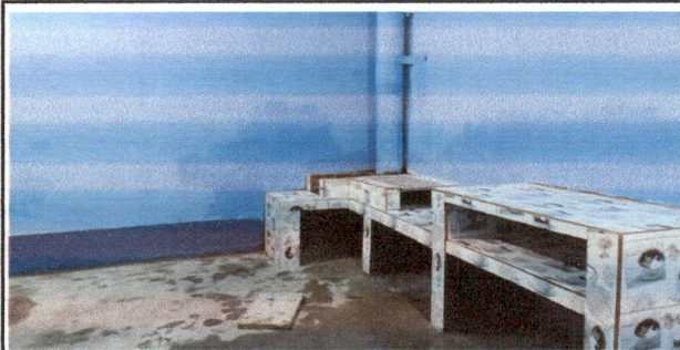
Foto 6: Instalación de azulejo en estufa rural
