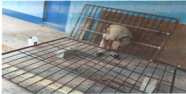
Foto 1: Sustitución de balcones de metal
