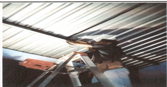
Foto 7 :Sustitución de focos ahorradores
