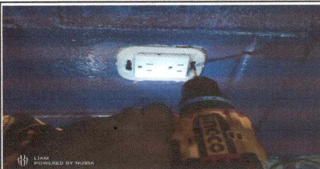
Foto 10: Sustitución de tomacorrientes dobles
