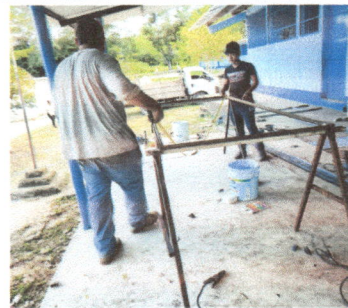
Foto 2: Sustitución de puerta
