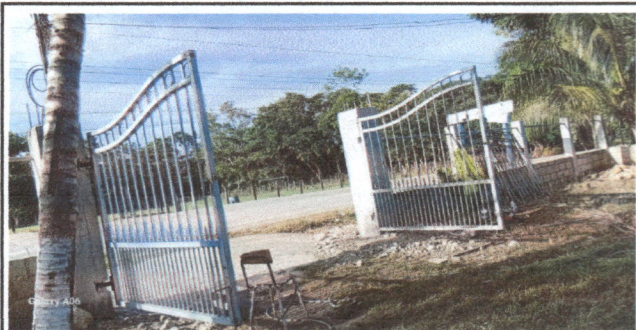
Foto 13 :Sustrucción de portón de metal
