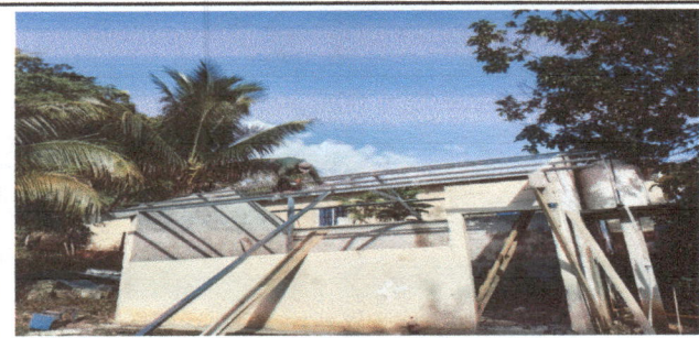
Foto 5: Sustitución de estructura de soporte de madera, por metal
