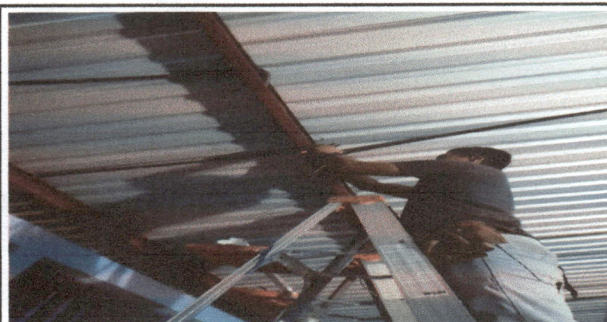
Foto 8:Sustitución de plafoneras
