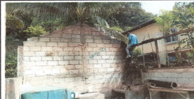
Foto 12:Repello en paredes de cocina
