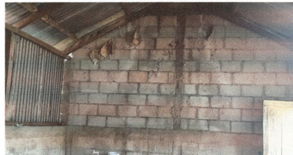
Foto 12:Repello en paredes de cocina
