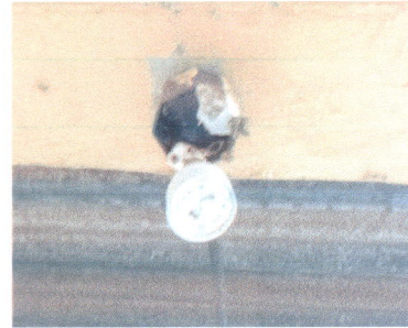
Foto 8:Sustrucción de plafoneras
