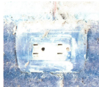
Foto 10: Sustrucción de tomacorrientes dobles
