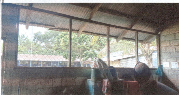
Foto 1: Sustitución de balcones de metal
