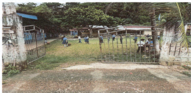
Foto 13 :Sustrucción de portón de metal
