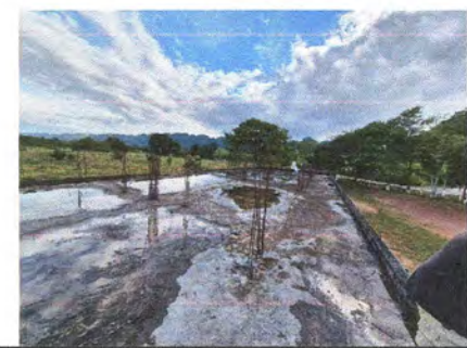
Mantenimiento y reparacion de losa
