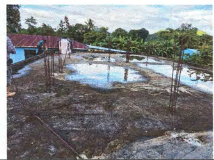
Impermeabilización de losa
