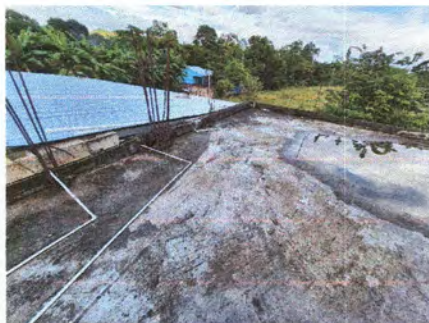
Reparación de bajada de agua pluvial, tubo PVC 3"
