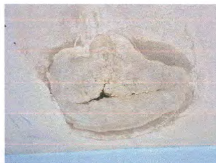
Aplicación de pintura en cielo de losa
