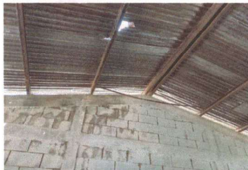
Foto 2: Sustitución de capote de ámina para lámina troquelada
