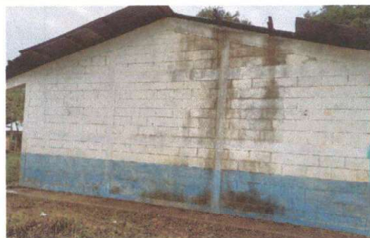
Foto 10: Pintura en muros exteriores e interiores
