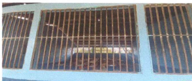
Foto 6: Sustitución de balcones de metal
