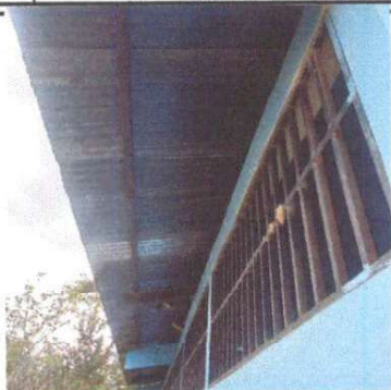
Foto 7: Mantenimiento a balcones de metal.
