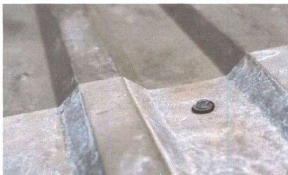
Foto 3: Sustitución de elementos de fijación
