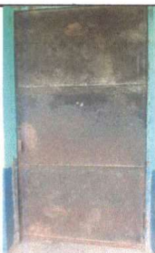
Foto 5: Sustitución de puerta de metal
