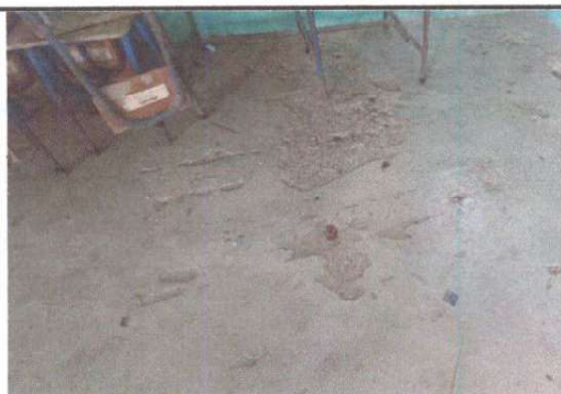
Foto 9: Sustitución de piso cemento líquido
