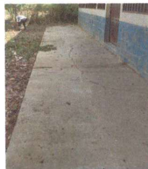
Foto 8: Reparación de piso de torta de concreto
