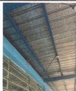
Mantenimiento a estructura de soporte de metal
