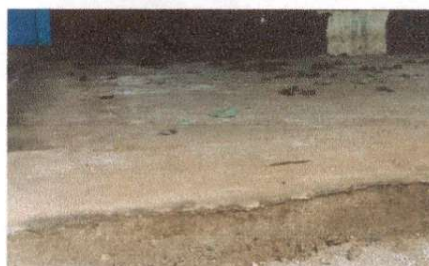
Reparación de piso de torta de concreto
