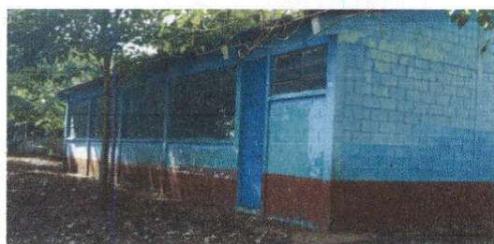
Pintura en muros exteriores e interiores
