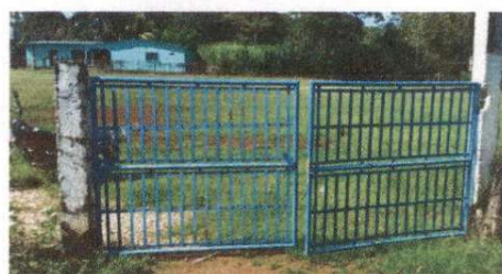
Mantenimiento a portones de metal
