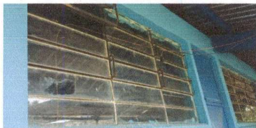
Mantenimiento a estructura de metal de ventana
