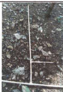
Sustitución de tubería línea principal
