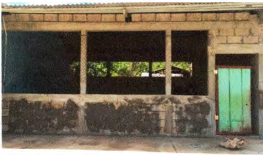
Foto: 5 Repellos en malas condiciones (se requiere el tallado y repello de los tres aulas)
