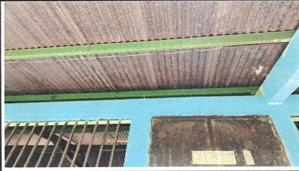
Foto 2: Mantenimiento a estructura de soporte de metal
