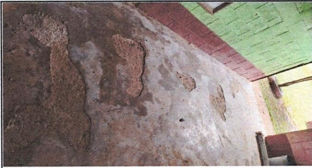
Foto 3: Reparación de piso de torta de concreto
