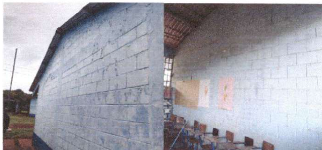
Foto 4: Pintura en muros exteriores e interiores.
