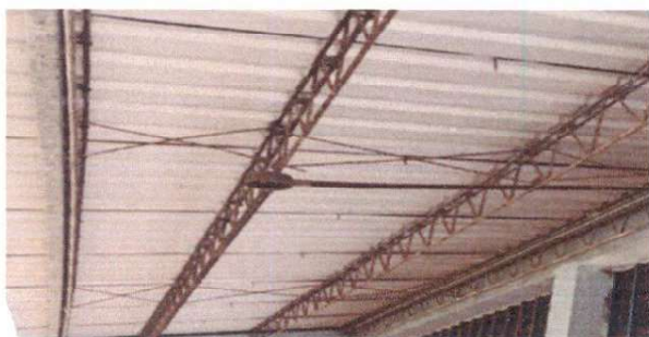
Foto 1: Sustrución de lamina, por lamina troquelada aluzinc calibre 26 modulo de aulas
