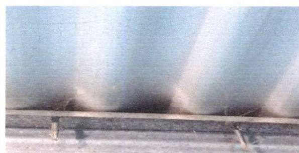
Foto 3: Sustrución de elementos de fijación.
