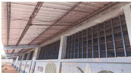
Foto 9: Mantenimiento de balcones de metal.
