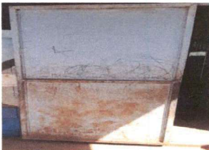
Foto 7: Mantenimiento a estructura (Lijado, cambio de tubo, cepillado sujeciones, aplicación de pintura)
