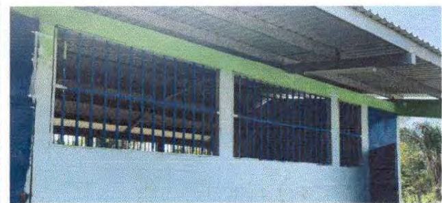
MANTENIMIENTO A BALCON DE METAL
