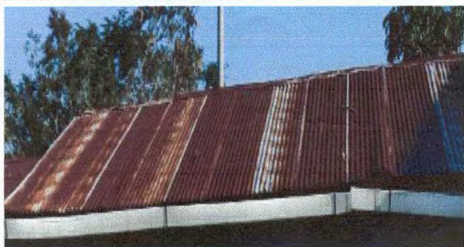
SUSTITUCIÓN DE LAMINA, POR LAMINA TROQUELADA ALUZIN CALIBRE 26
