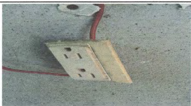
SUSTITUCION DE TOMACORRIENTES DOBLE
