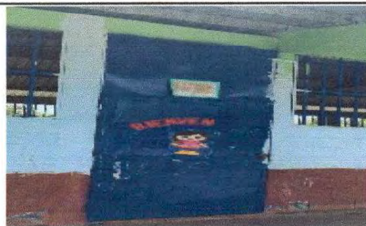
MANTENIMIENTO A ESTRUCTURA (lijado, cambio de tubo, cepillado, lijado y aplicación de pintura)
