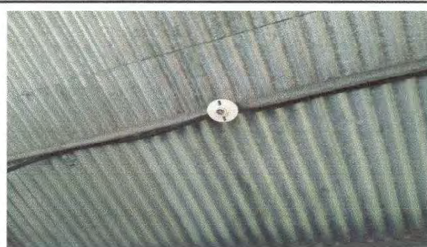
SUSTITUCIÓN DE PLAFONERA
