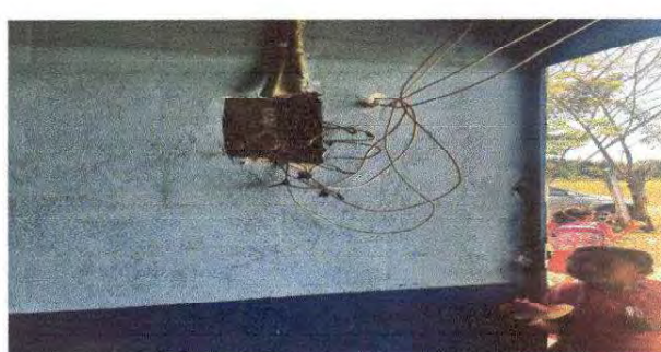
REPARACION DE CABLEADO ELECTRICO
