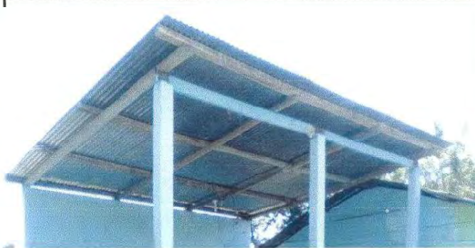
SUSTITUCIÓN DE ESTRUCTURA DE MADERA, POR METAL.
