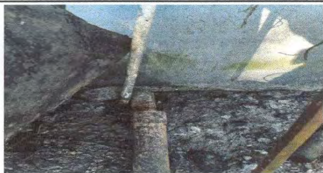
SUSTITUCIÓN DE TUBARIA PRINCIPAL
