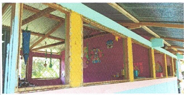
Foto 5: Sustitución de balcones de metal
