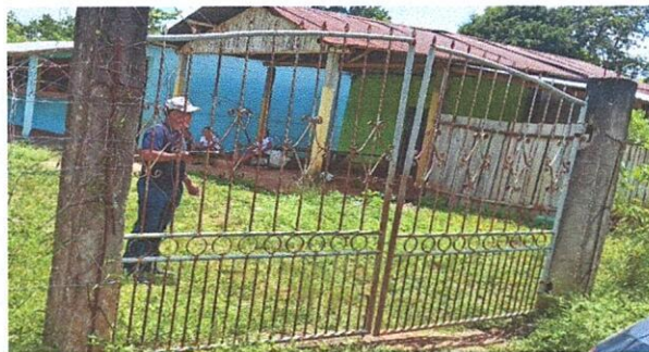
Foto 2: Mantenimiento a portones de metal
