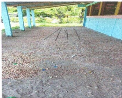
Foto 1: Reparación de piso de torta de concreto
