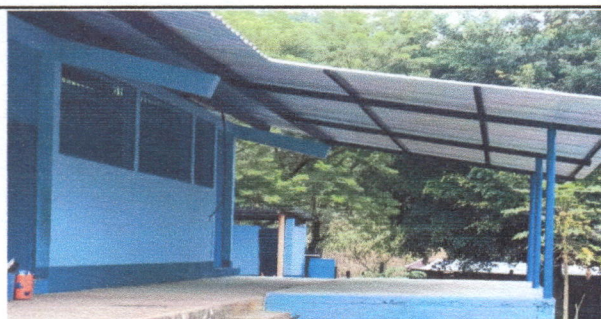
Foto 3: Reparación de piso de torta de concreto
