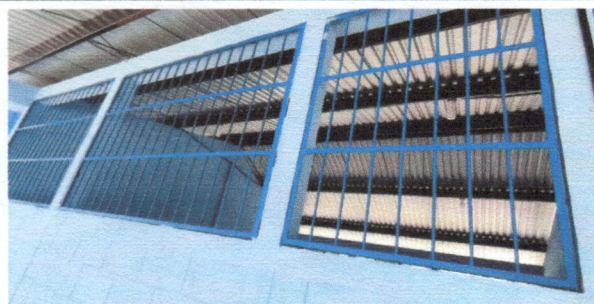
Foto 1: Sustitución de balcones de metal
