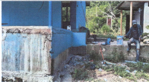
Foto 3: Reparación de piso de torta de concreto
