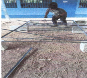
Foto 1: Sustitución de balcones de metal
