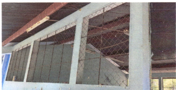
Foto 1: Sustrucción de balcones de metal
