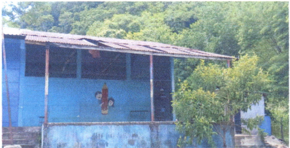
Foto 6: Pintura en muros exteriores e interiores
