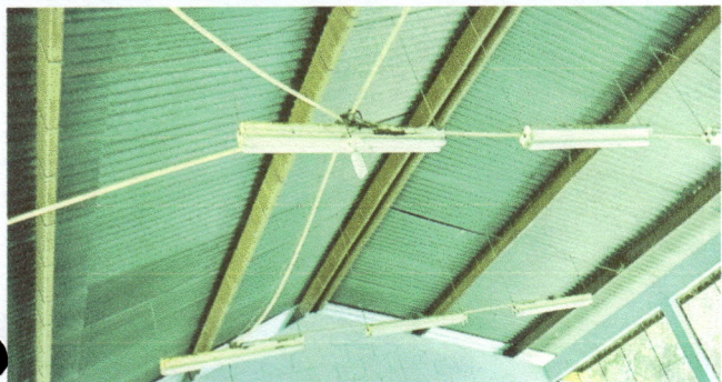
Foto 7 :REPARACION DE SISTEMA ELÉCTRICO
