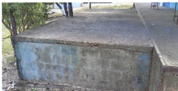
Foto 3: Reparación de piso de torta de concreto
