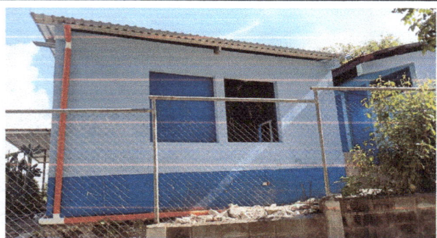
Foto 9: Reparación de repello y cernido de paredes
