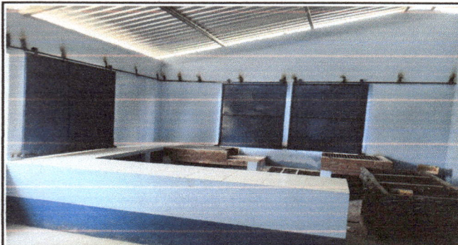
foto 8: Reparación de cocina
